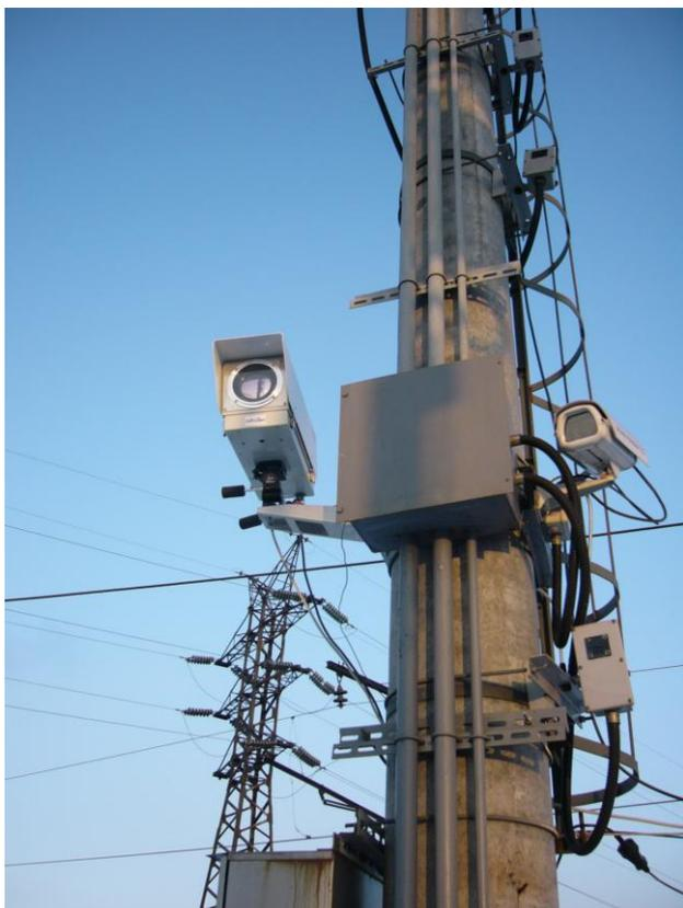
Комплексный осмотр проходящего состава с получением данных об уровне и равномерности загрузки вагонов жидкими и сыпучими грузами.
